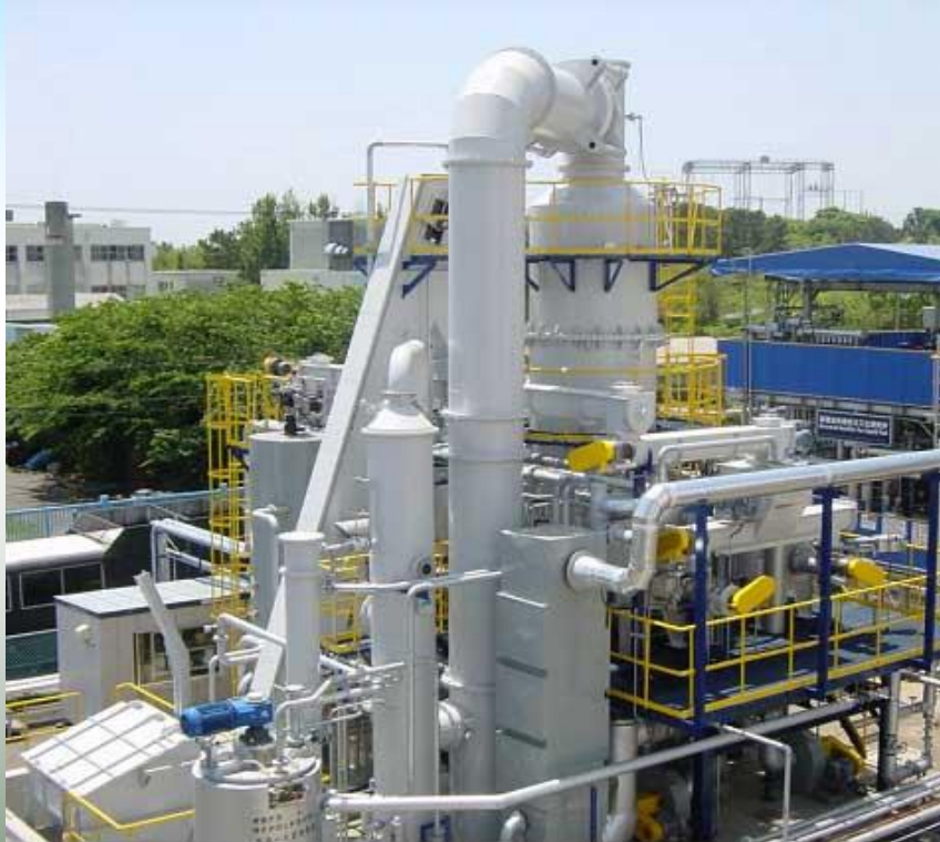
5トン/日バイオマス/廃棄物炭化ガス化実験設備
